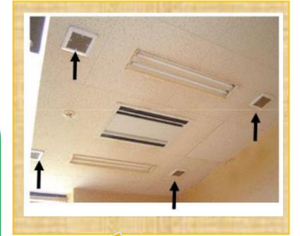
喫煙室の出入口から漏れないための排気風量を確保するために、天井扇を4台設置した例の写真です。
